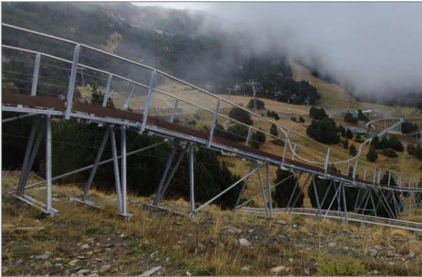
Fotografía 1. Ejemplo de cimentación hincada para pista de trineo en otra ubicación.
