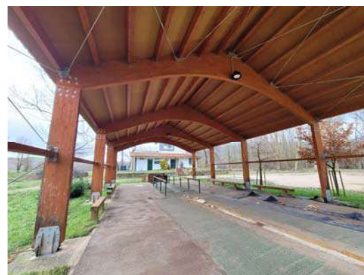
Imagen cubierta, pórticos y correas
