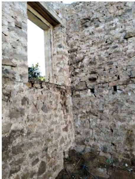
Fotografía 3. Grietas esquina interior suroeste.
