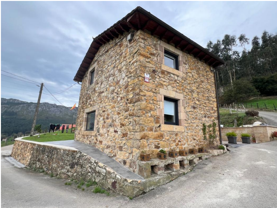
Estado reformado. Fachada sur y oeste. Tramo muro original y reconstruido.
