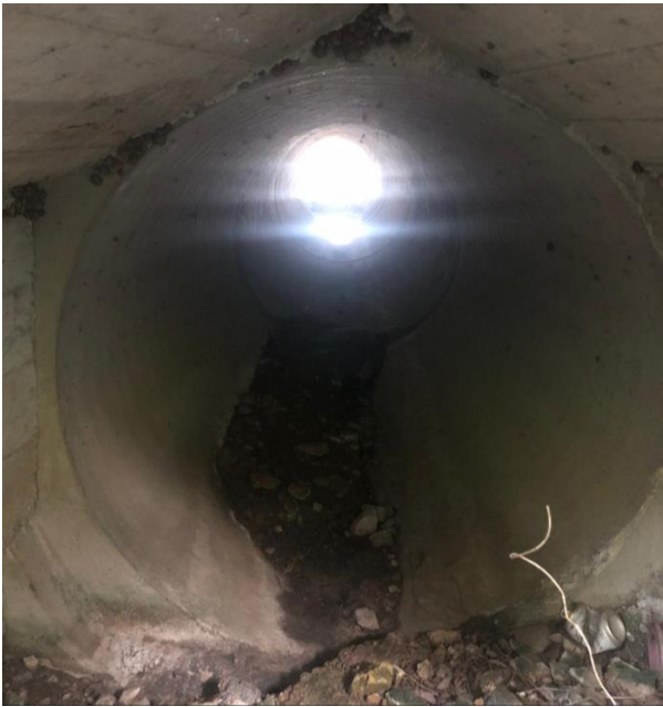
Fotografía del paso bajo la carretera CA-131. Se trata de un tubo de hormigón prefabricado de 800mm de diámetro.
