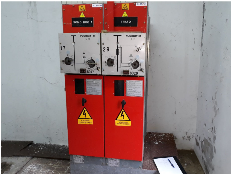
Foto 2: Celdas de M.T. existentes en el C.T.
