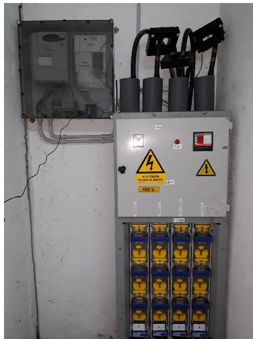
Foto 4: C.B.T.-Trafo2 existente en el C.T.
