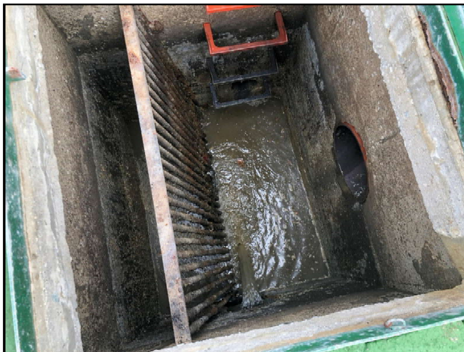
Imagen 2.- Interior de la arqueta de desbaste y alivio.
