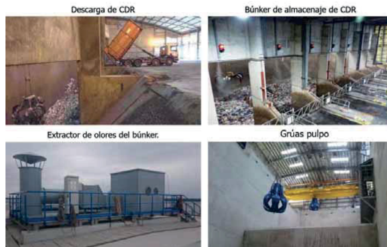
Figura 1. Recepción, manipulación y almacenamiento de CDR. Fuente: Anteproyecto.
