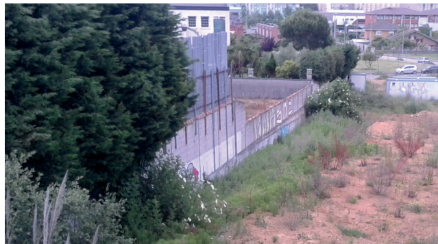
Detalle muro de contención, y cerramientos diversos
