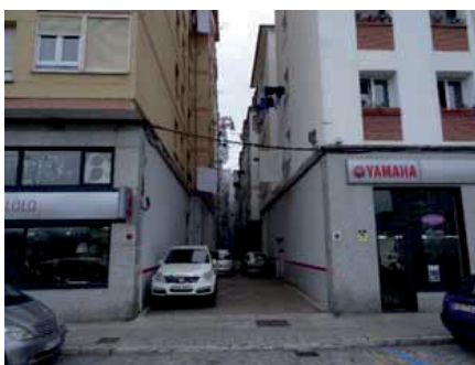
Vista pasaje desde solar
