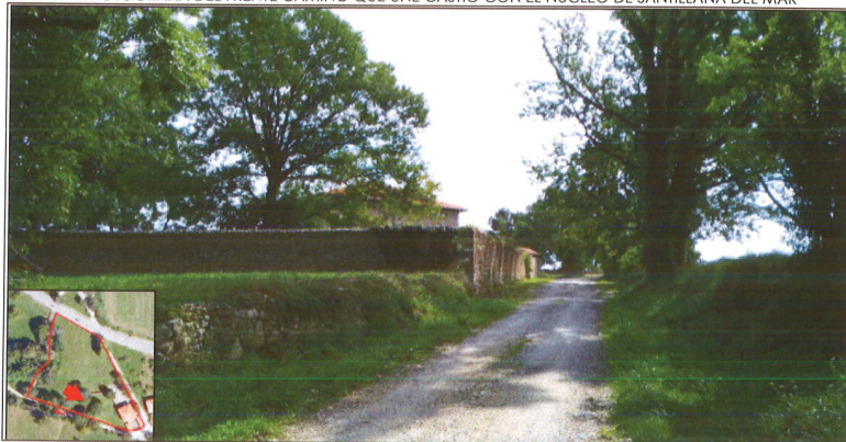
FIGURA 11. FOTOGRAFIA DESDE EL OESTE CON EL CIERRE DE MAMPOSTERIA DE LA HUERTA.
