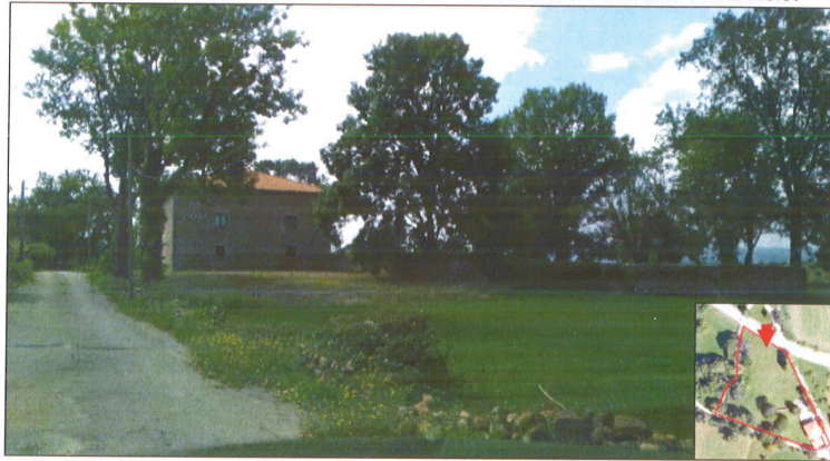
FIGURA 7. FOTOGRAFIA DEL FRENTE NORTE DE LA EDIFICACION Y EL CIERRE DE MAMPOSTERIA DE LA HUERTA
