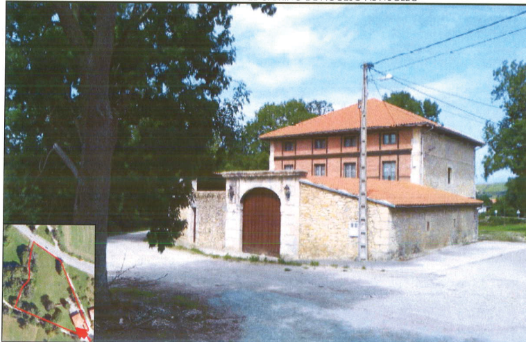
FIGURA 9. FOTOGRAFIA DEL FRENTE SUR DE LA EDIFICACION Y EL CRUCE DE CAMINOS
