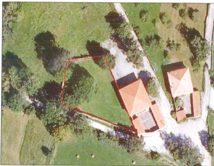
FIGURA 6. FOTO AEREA SEÑALANDO ZONA CERRADA CON MURO DE MAMPOSTERIA JUNTO AL EDIFICIO.
