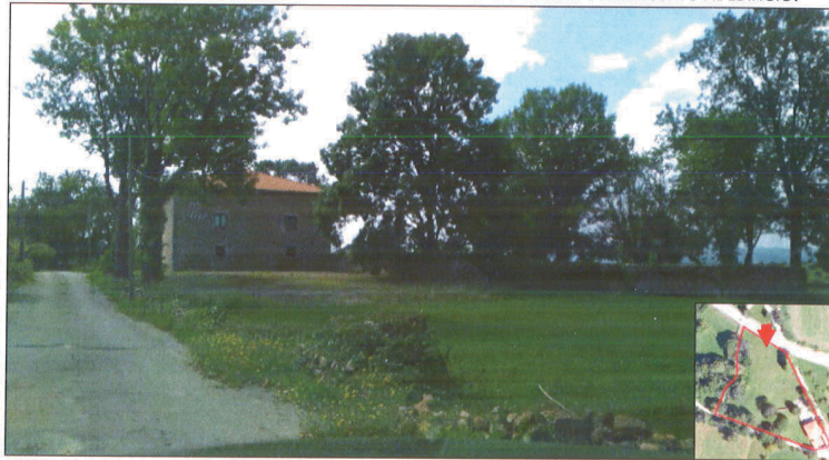
FIGURA 7. FOTOGRAFIA DEL FRENTE NORTE DE LA EDIFICACION Y EL CIERRE DE MAMPOSTERIA DE LA HUERTA
