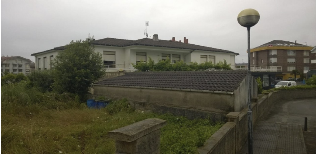
Imagen 5.- Garaje-almacén que se demuele parcialmente, en el lugar en donde se planea el nuevo vial.
