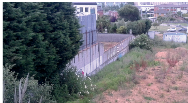
Detalle muro de contención, y cerramientos diversos
